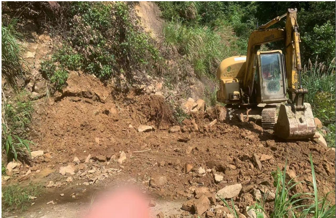
图 2-15 双牌县白果脚村路面整修工程现场
